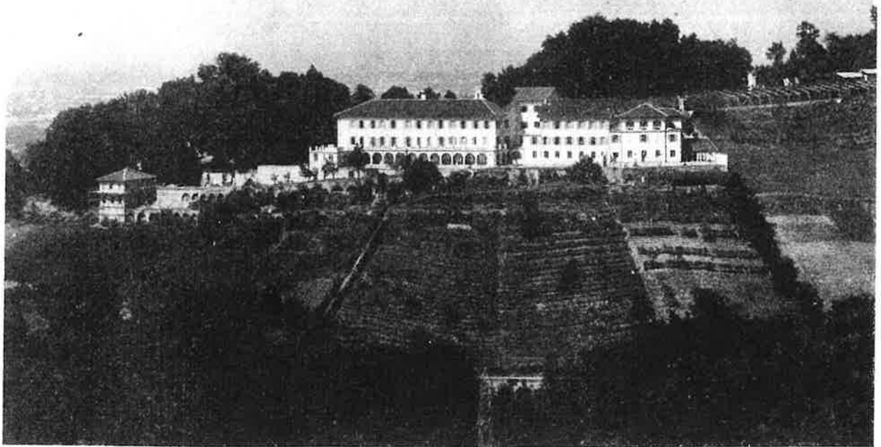
San Mauro Torinese : il "Romitaggio San Mauro", dopo i lavori di ampliamento e restauro
